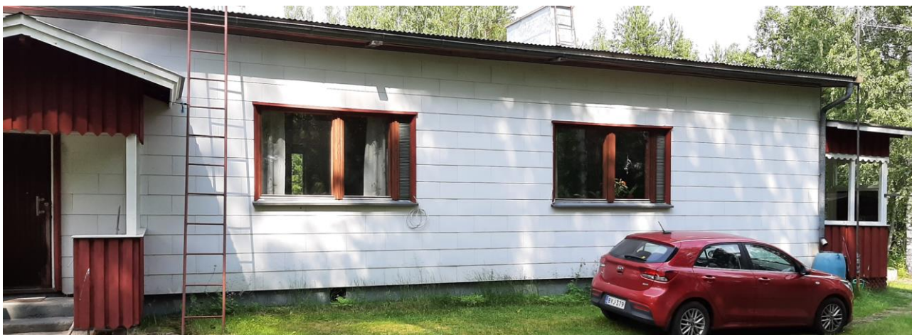
Pohjoisin, seitsemäs rakennus (Partanen, julkisivumuutoksia, säilyy (RA-2).
