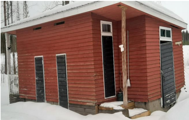
Kokin huonokuntoiset talousrakennukset. Muun muassa sokkelit poikki useasta kohdasta.
