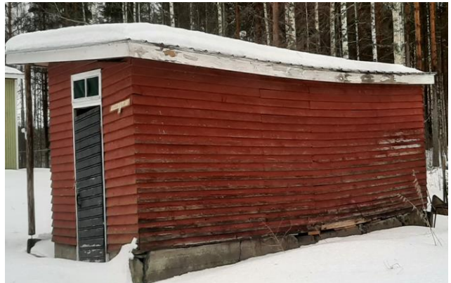
Kokin huonokuntoiset talousrakennukset. Muun muassa sokkelit poikki useasta kohdasta.
