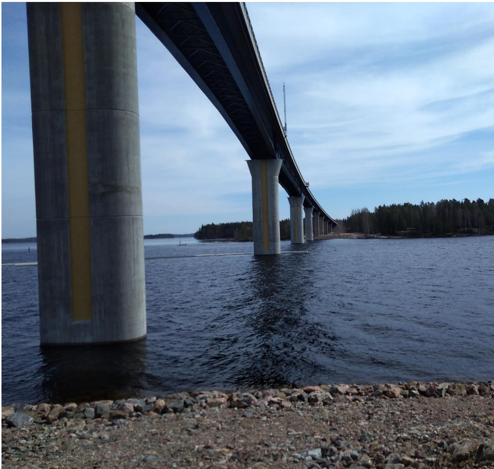
Kuvassa uusi Vekaransalmen ylittävä silta 7/2021
