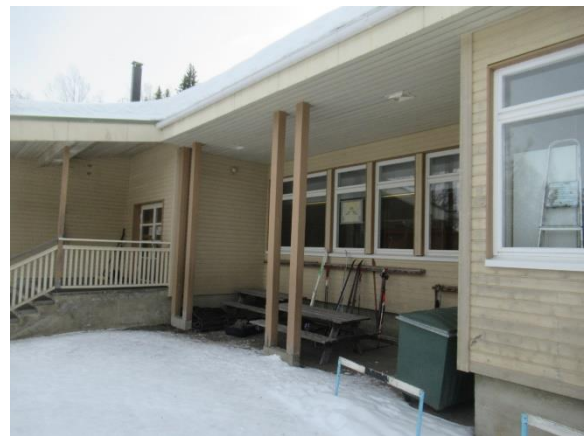
Kivilaatoitusta näkyvissä syvennyksessä
