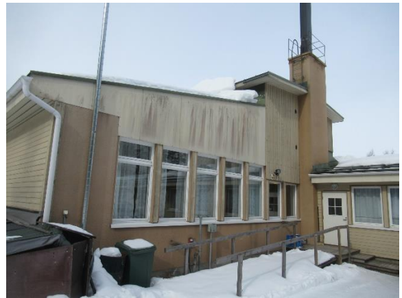
Vanhan osan levyverhoilua ja rappausta
