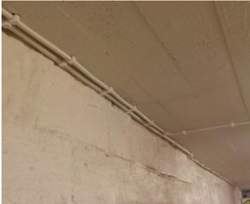
Kaapelin kiinnitystä johtokiinnikkeillä
