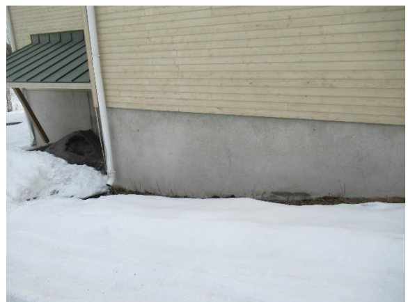
Laajennusosan sokkeliä/kellarin maanvastaista seinää
