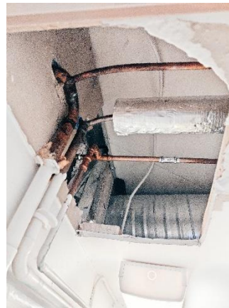
Avattu alakatto ja putkien korjauksia
