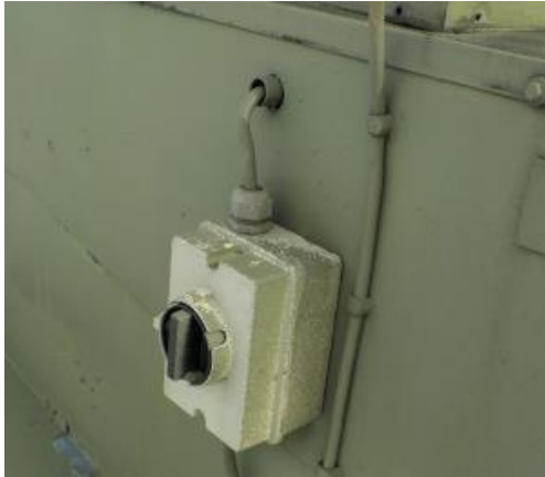
Läpivienti vesikatolla huippuimurille
