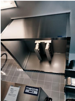
Keittiön poistoilmahuuva
