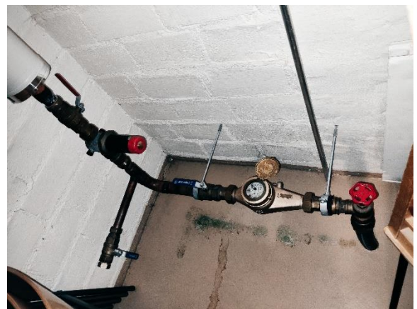
Päävesimittari
