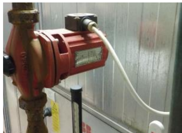
Pumpun sähköistys IV-konehuoneessa
