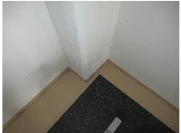
Yleiskuva uuden osan kellarikerroksen pilari-lattia-seinäliittymästä.
