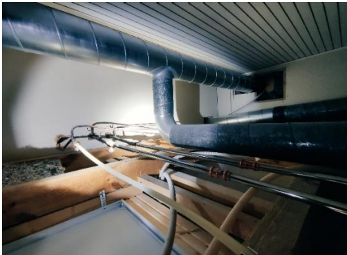
WC tilojen yllä korjattuja putkiosuusia.
