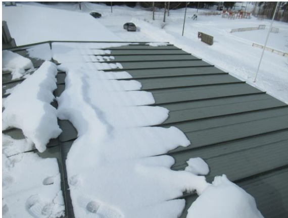
Yleiskuva vanhan osan vesikatolta
