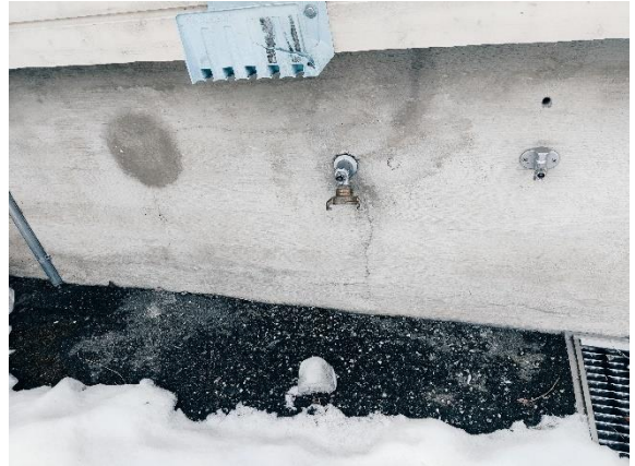
Poistettu painovoimainen ilmanvaihto kellari-kerroksesta
