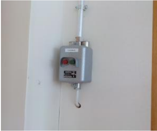
Puruimurin ohjauskytkin teknisentyön tiloissa
