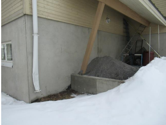
Betonirakenteinen tukimuuri uuden osan vierustalla
