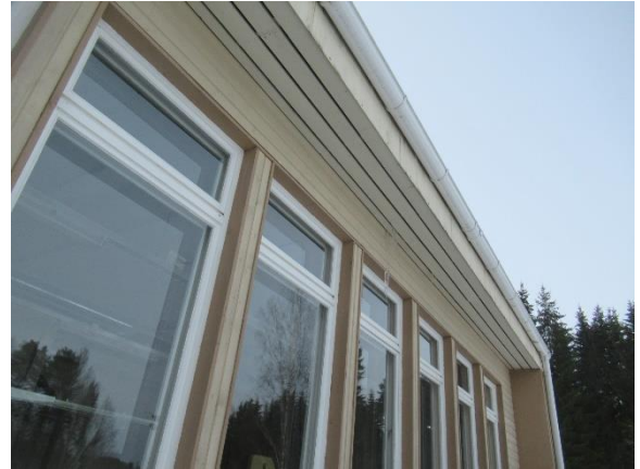
JÄÄPUIKKOJA VANHAN OSAN RÄYSTÄÄNALUSSESSA
