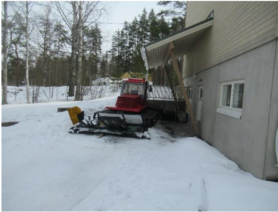
Laajennusosan kellarikerroksen sisäänkäynnin lippa
