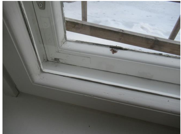
Alkuperäisen osan ikkunoita
