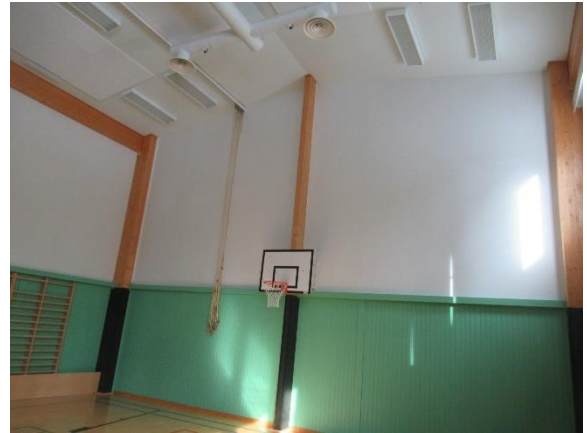
Laajennusosan liikunta-/juhlasalin puupilari-palkkirakenteita
