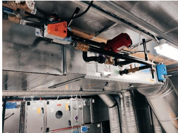
IV-koneen patterin kytkentä ja säätöryhmä
