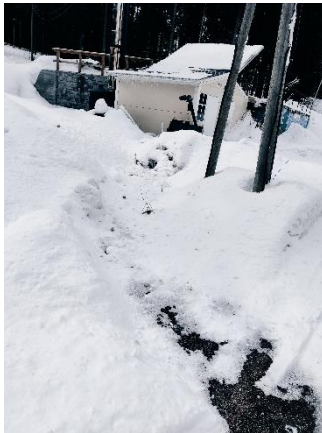
Lämpölaite, sulanut maa
