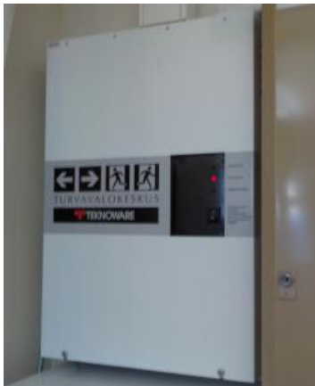
Turvavalokeskus näyttämön läheisyydessä
