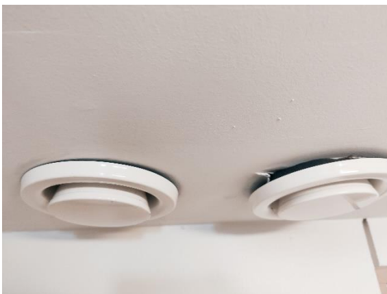
Poistoilmaventtiilit
