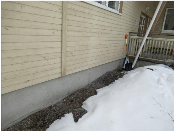
Laajennusosan rakennuksen vierustaa
