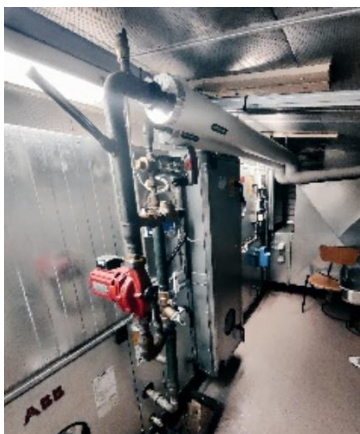
IV-koneen patterin kytkentä ja säätöryhmä
