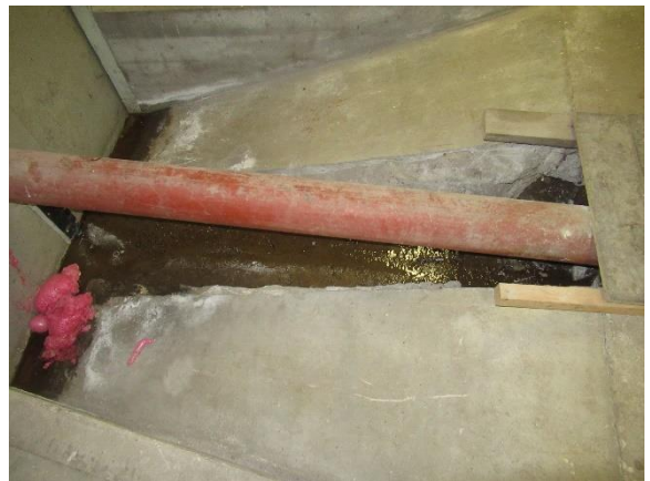
Entisen polttoainevaraston lattiassa kulkee "hulevesioja".
