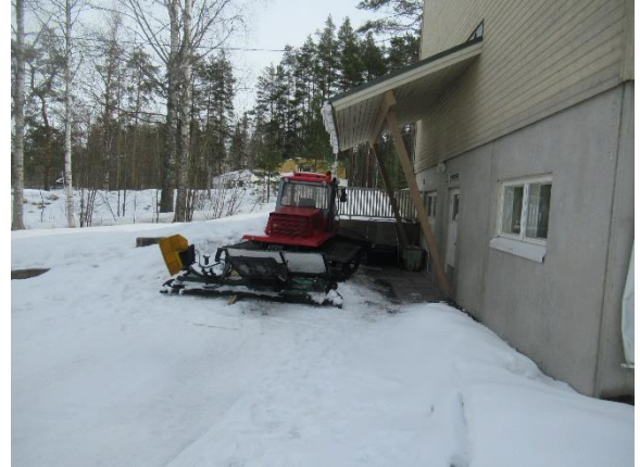
Betonirakenteinen tukimuuri laajennusosan kellarin sisäänkäynnin vierustalla
