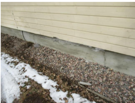
Vanhan osan eteläseinustan sokkeliä
