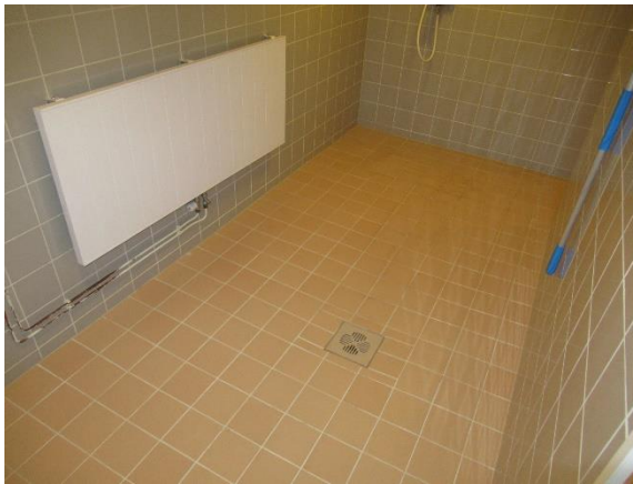
Kellarikerroksen saunasaston pesuhuone
