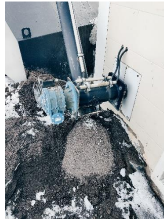
Tuhkanpoisto jäätyy talvisin, irrotettu liittokistaan
