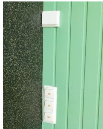
Kalusteiden asennusta liikuntasalissa
