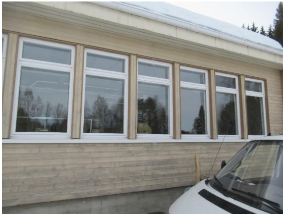
Alkuperäisen osan ikkunoita
