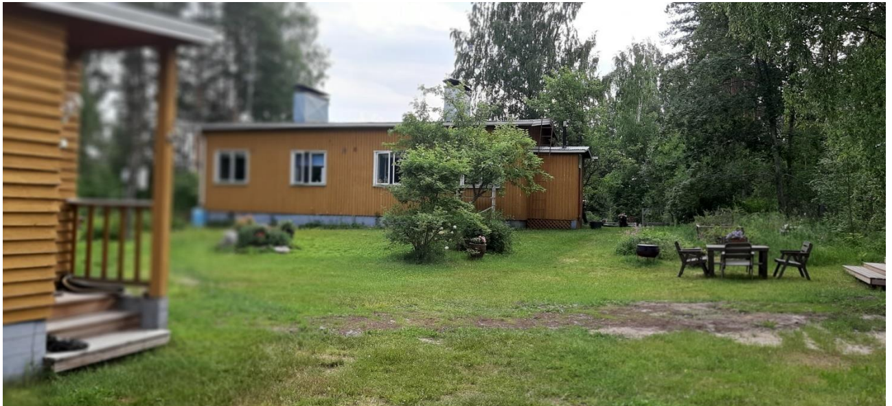
Tilalla Kesämaa (-3-32) oleva entinen parakkirakennus. Hulevesivahinkoja, korjattu mm. kellaria ja rakenteilla uusi ranta sauna; esitetään säilytettäväksi loma-asuntona.
