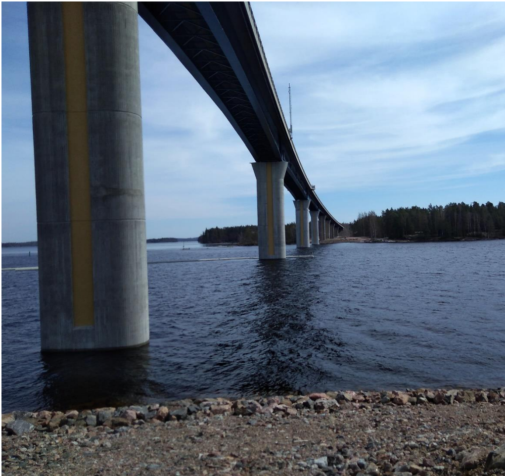
Kuvassa uusi Vekaransalmen ylittävä silta 7/2021
